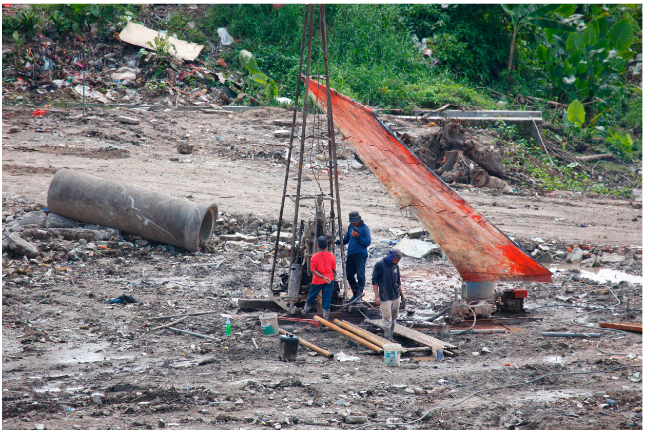
Arbeitsmigranten auf einer Baustelle in Kuala Lumpur, Malaysia. Foto: Heiner Heine
