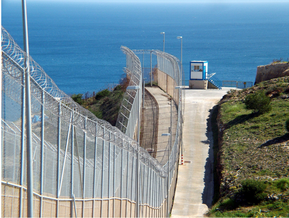
Der Grenzzaun zu den spanischen Exklaven Melilla und Ceuta, bestehend aus zwei Zäunen von sechs Metern Höhe, gesäumt von Stacheldrahtrollen mit messerscharfen Zacken. Außerdem sind Wärme- und Infrarotkameras installiert, die festsetzende Flüchtlinge registrieren. Die Migranten werden von spanischen Sicherheitskräften festgenommen und durch Türen im Zaun nach Marokko abgeschoben. Foto: José Palazón
